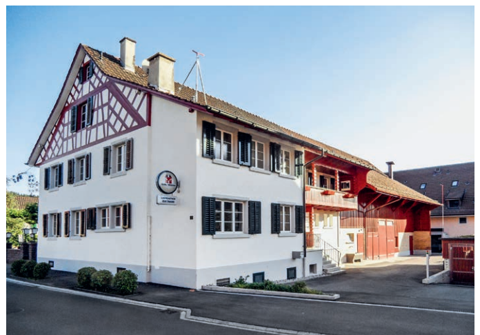
Das Bundesgericht hält fest, dass das Willkürverbot auch bei der Inventarisierung potenziell schutzwürdiger Bauten zu beachten ist. Bild: Gasthof Zur Traube in der Gemeinde Dägerlen (ZH) bei Winterthur.
